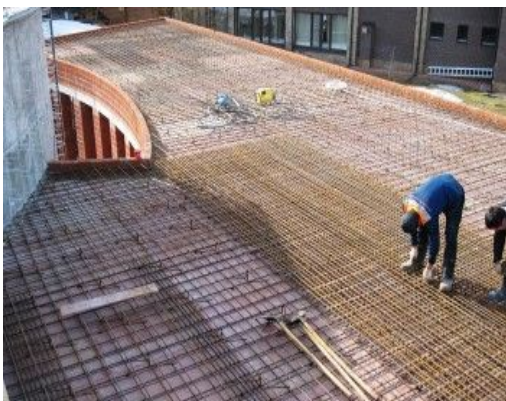
Рис. 1. Монолітне ребристе перекриття
