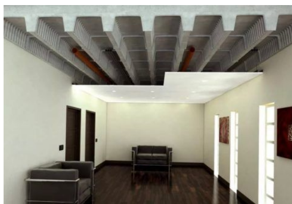
Рис. 1. Монолітне ребристе перекриття
