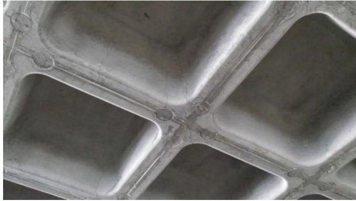
Рис. 2. Монолітне кесонне перекриття
