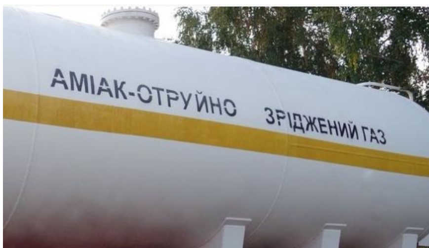
Стационарна ємність з аміаком на виробництві
