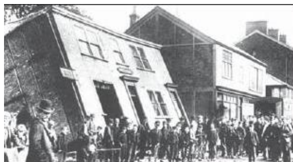
Рис. 2. Осідання поверхні, будівель та споруд внаслідок гірничих робіт (Чилі)
