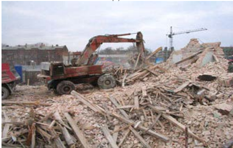
Рис. 2. Малопродуктивна робота екскаватора з ковшем на розбиранні зруйнованих будинків у центрі Дніпропетровська (реконструкція, 2006)
