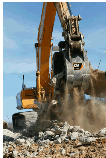
Рис. 1. Використання екскаваторів для розбирання завалу та зруйнованого Торговельного центру у Нью-Йорку: а – з ковшем; б – з ковшем та захватом у вигляді щелпи
