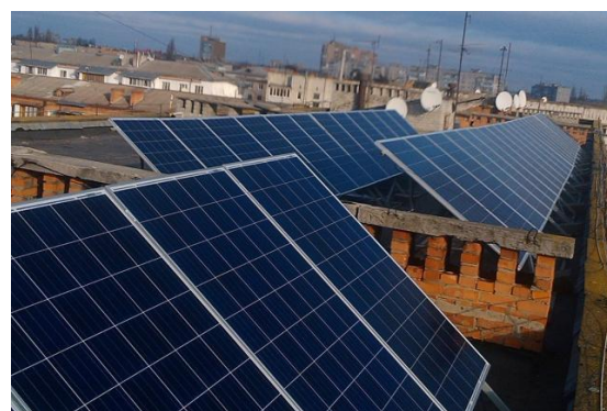
Рис. 2. Встановлення сонячних панелей на плоскому даху
