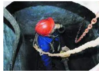
Рис. 3 – Спорядження робітника при спуску в колодязь
