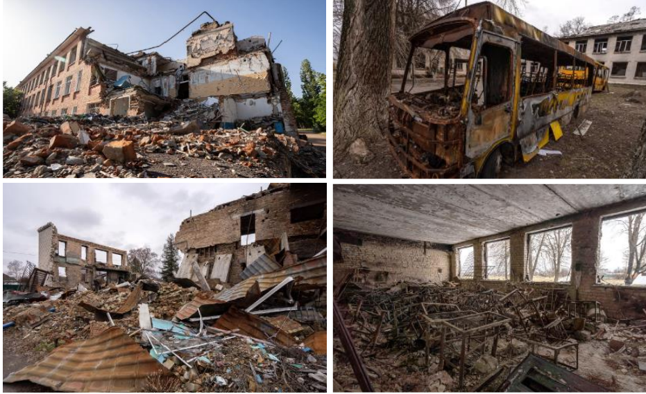
Рисунок 2 – Типові руйнування будівель і споруд ЗЗСО під час розвитку надзвичайної ситуації військового характеру
