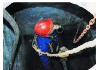
Рис. 3 – Спорядження робітника при спуску в колодязь
