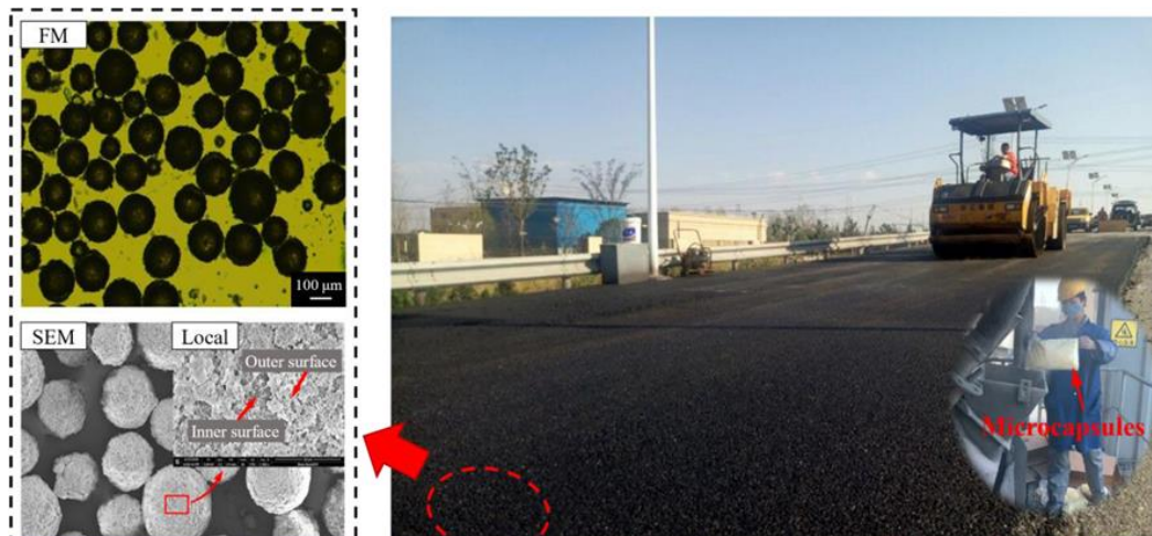
Рис. 1. Самовідновлювальний асфальт на Fenghai Road, Шанхай [2]
