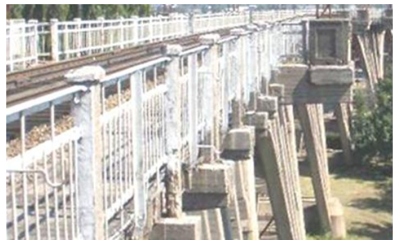
Рис. 1. Загальний вигляд моста
