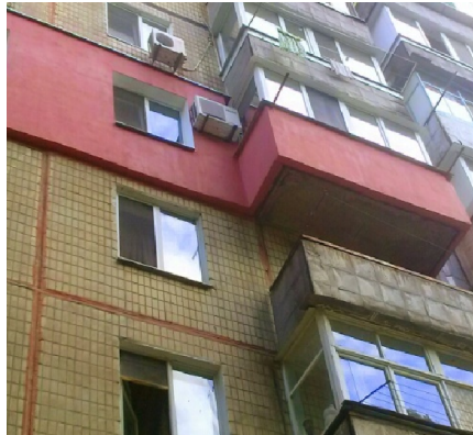
Рис. 2.2. Варіанти застосування систем зовнішньої теплоізоляції балконних плит:
