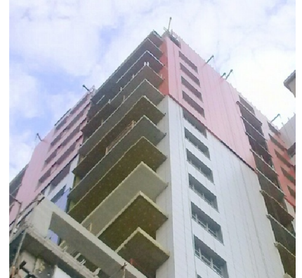
Рис. 2.2. Варіанти застосування систем зовнішньої теплоізоляції балконних плит:
