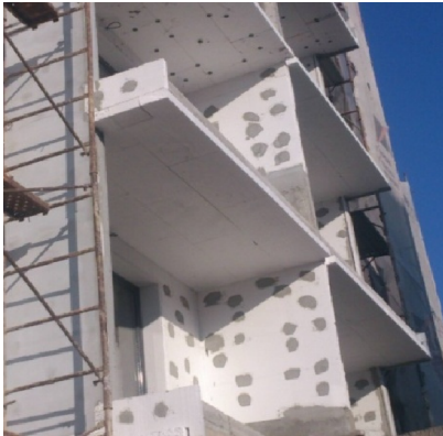
Рис. 2.2. Варіанти застосування систем зовнішньої теплоізоляції балконних плит:
