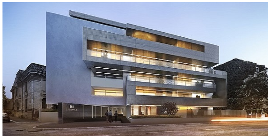
Рис. 3.1. Будівництво житлового комплексу «Vernescu Residence» у м. Бухарест (Румунія)
