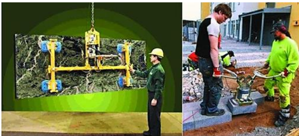
Рис. 7.39. Вакуумна траверса для монтажу мармурового слябу (ліворуч). Вакуумний монтажний захват для встановлення гранітних блоків при мощенні.
