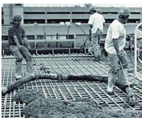
Рис. 7.35. Переміщення шланга з бетоном над арматурним каркасом
