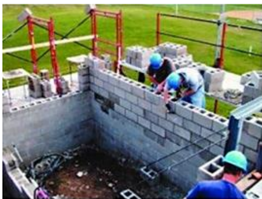
Рис. 7.13. Робота на звичайних, незакритих рамних риштуваннях
