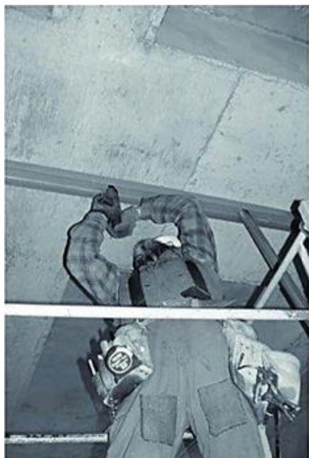
Рис. 7.22. Робота з будівельним пістолетом над головою
