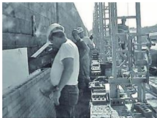
Рис. 7.14. Робота на різнорівневих риштуваннях
