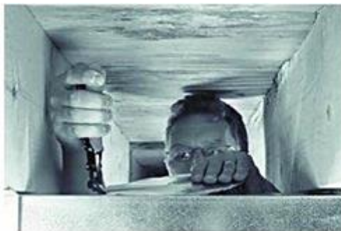
Рис. 7.53. Використання вертикальних ножиць у повітроводі (стиснені умови)
