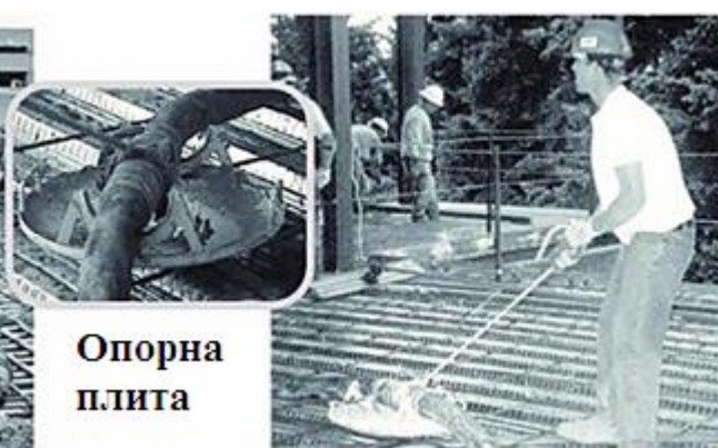
Рис. 7.36. Переміщення шланга за допомогою опорної плити та ручки-гака
