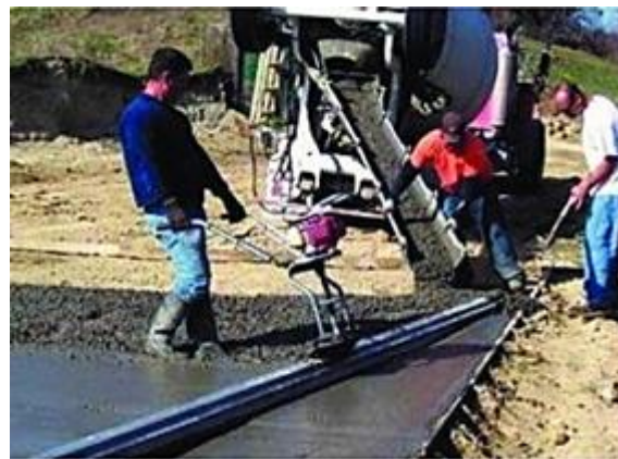
Рис. 7.7. Автоматизоване вирівнювання бетону
