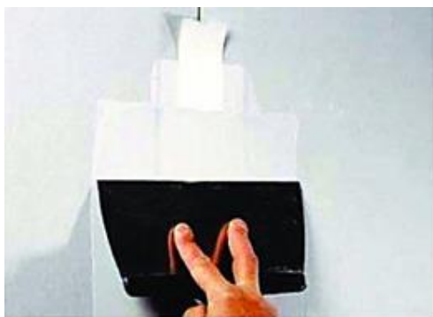
Рис. 7.24. Виконання шпаклівки стін вручну
