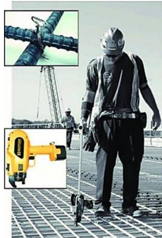
Рис. 7.9. В'язання арматури за допомогою інструменту
