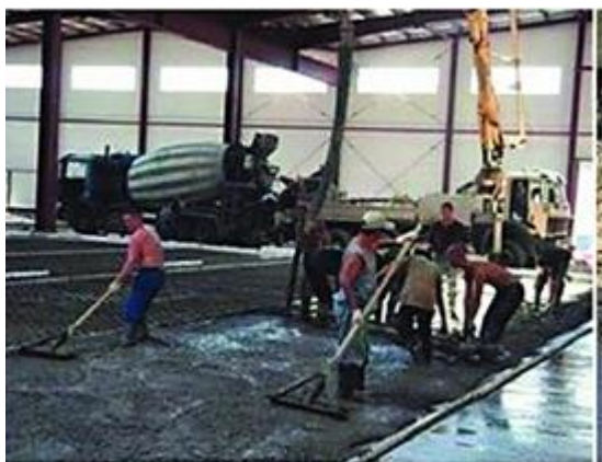
Рис. 7.6. Вирівнювання бетону вручну
