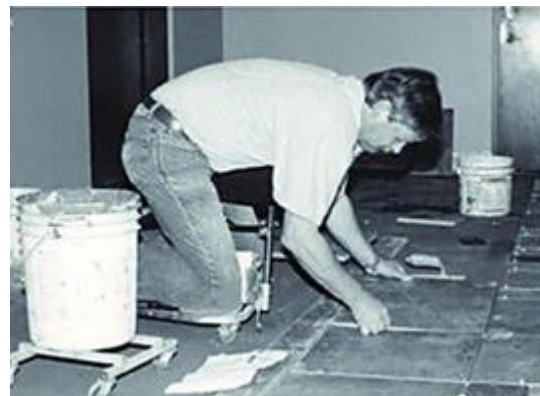
Рис. 7.12. Укладання плитки за допомогою пересувної платформи для колін з опорою для грудей
