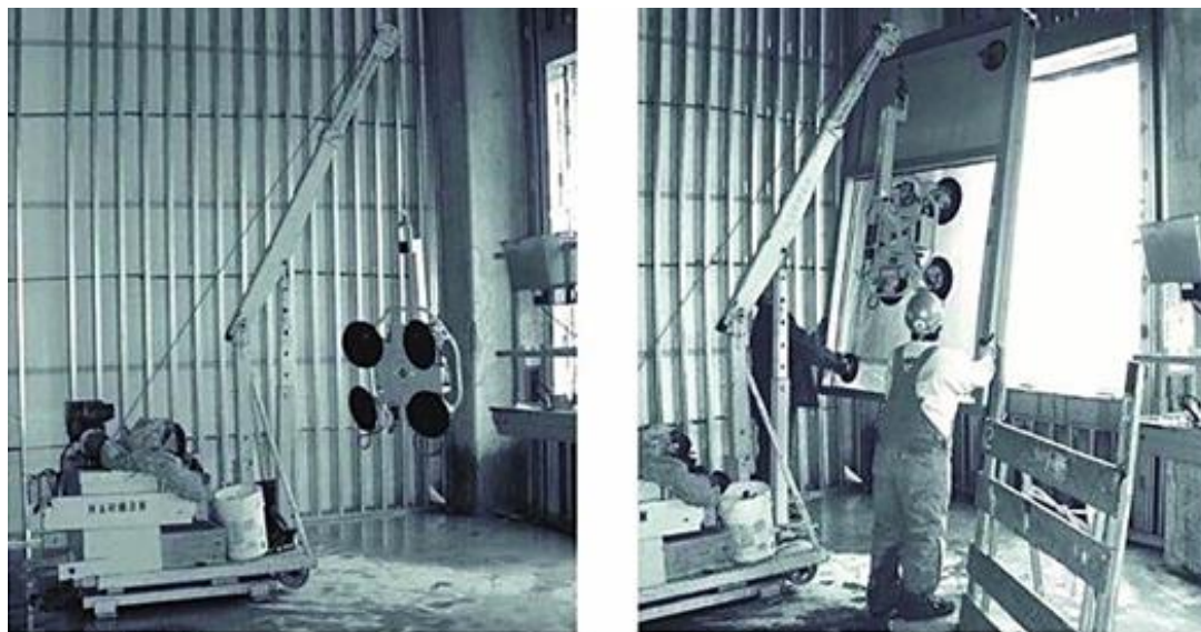
Рис. 7.29. Використання електровакуумного підйомнику при підйомі та переміщенні віконного блока до місця монтажу
