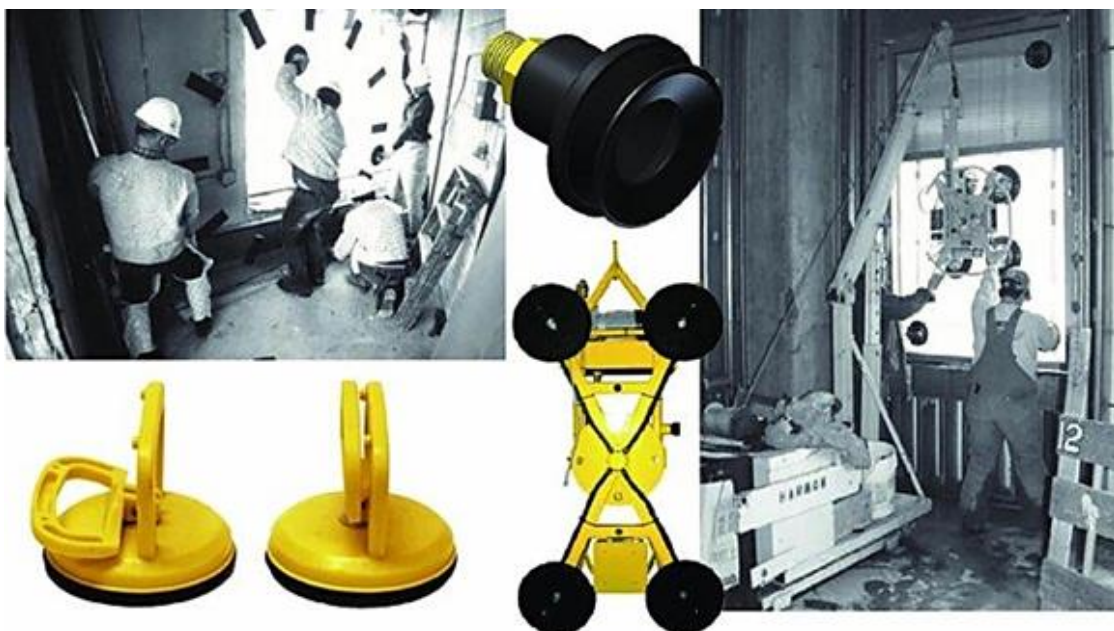
Рис. 7.37. Установка вікна за допомогою ручних присосок (необхідність піднімати вантаж)
