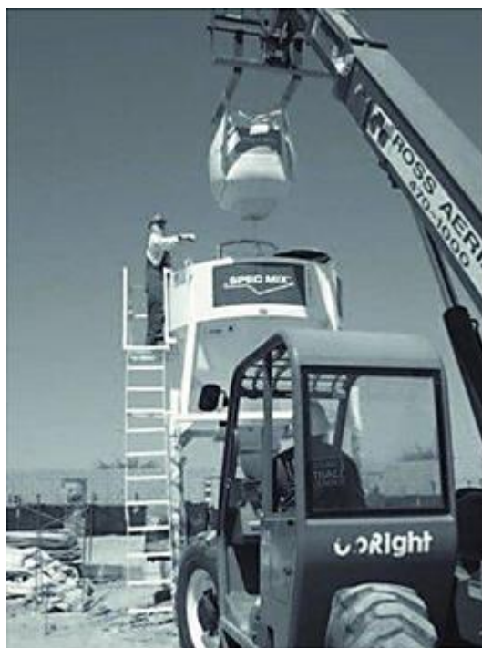
Рис. 17.34 Завантаження бункера
