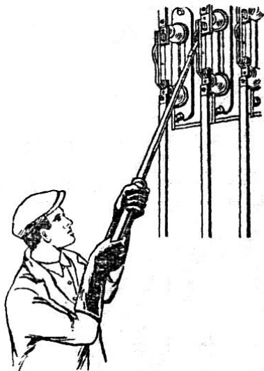
Рис. 1.51. Операції з однополюсними роз'єднувачами
