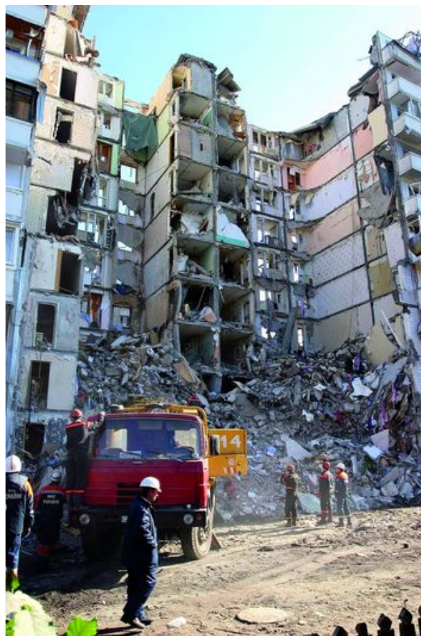
Рис. 10.14. Наслідки вибуху газу 13 жовтня 2007 року у житловому будинку (м. Дніпропетровську по вул. Мандриківській, 127)
