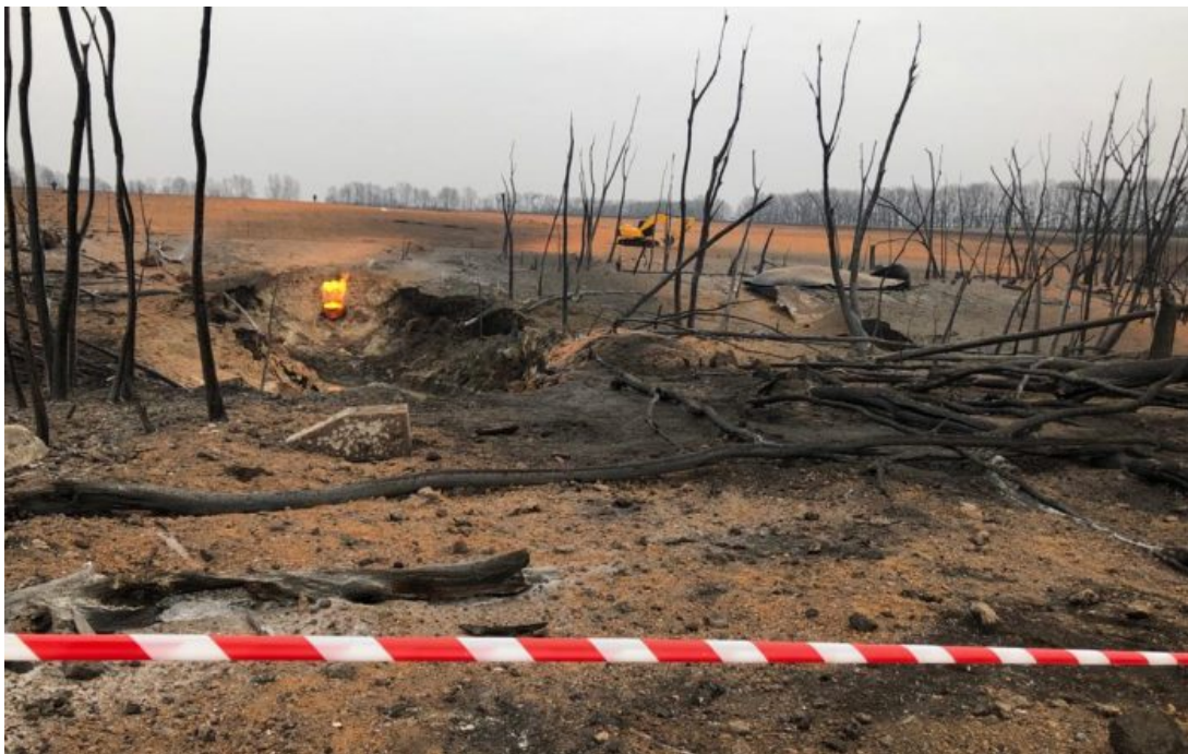
Рис. 8.8. Аварія на магістральному експортному газопроводі «Уренгой – Помари – Ужгород», 2021 рік
