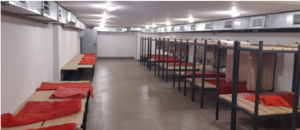
Рис. 9.12. Обладнання приміщень захисних споруд дворівневими металевими ліжками
