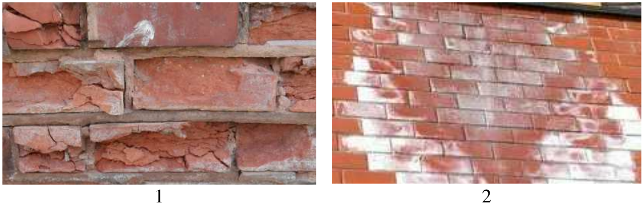
Рис. 2.5. Пошкодження кам'яних конструкцій: 1 – розшарування (деструкція); 2 – вилуговування
