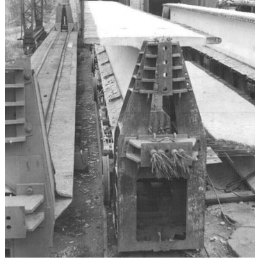
Рисунок 6.1 – Попередньо-напружена балка на стенді
