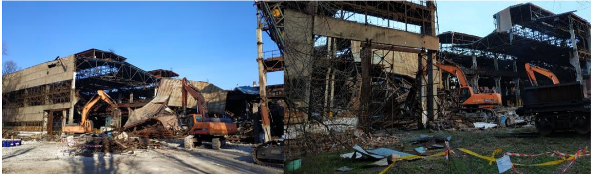
Рис. 4. Очищення ділянки від зруйнованих конструкцій (фото до)
