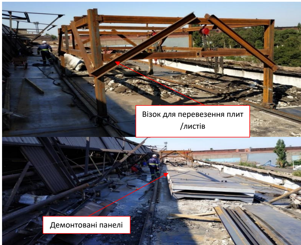
Рис. 17. Фото демонтажу покрівлі за допомогою спеціального візку
