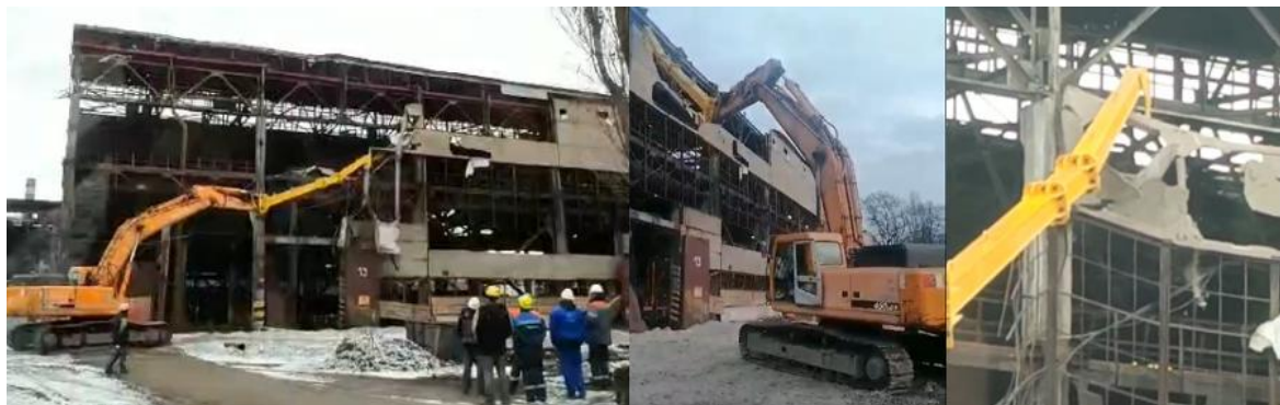
Рис. 10. Фото виконання робіт
