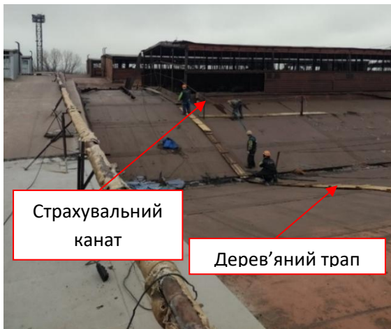
Рисунок 16а. Схеми встановлення трапів
