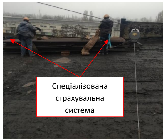
Рис. 16б. Схеми спец. страхувальної системи
