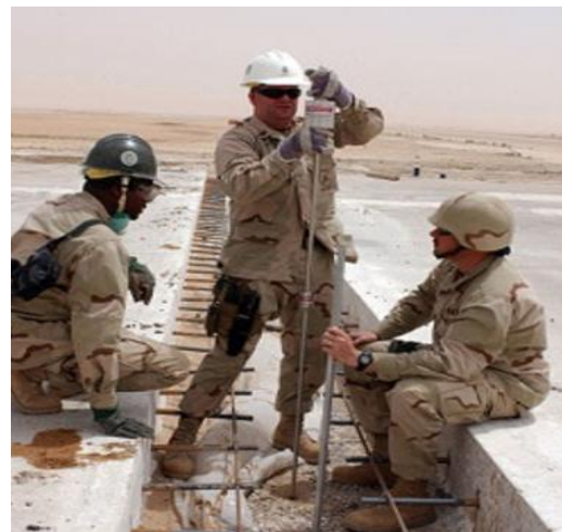
Рис. 2. Застосування пенетрометрів інженерними підрозділами армії США при будівництві злітно-посадкової смуги
