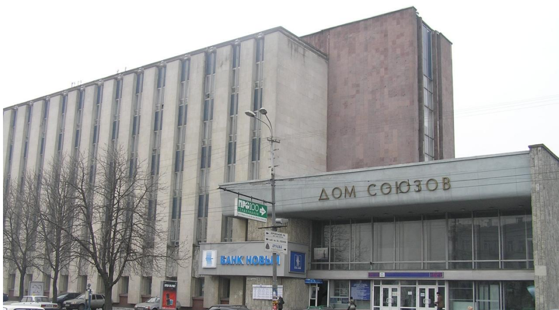
Рис. 3.8 Общий вид здания
