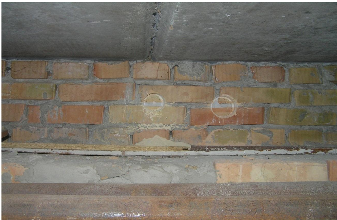
Рис. 3.13. Участок «новой» стены в месте отбора образца
