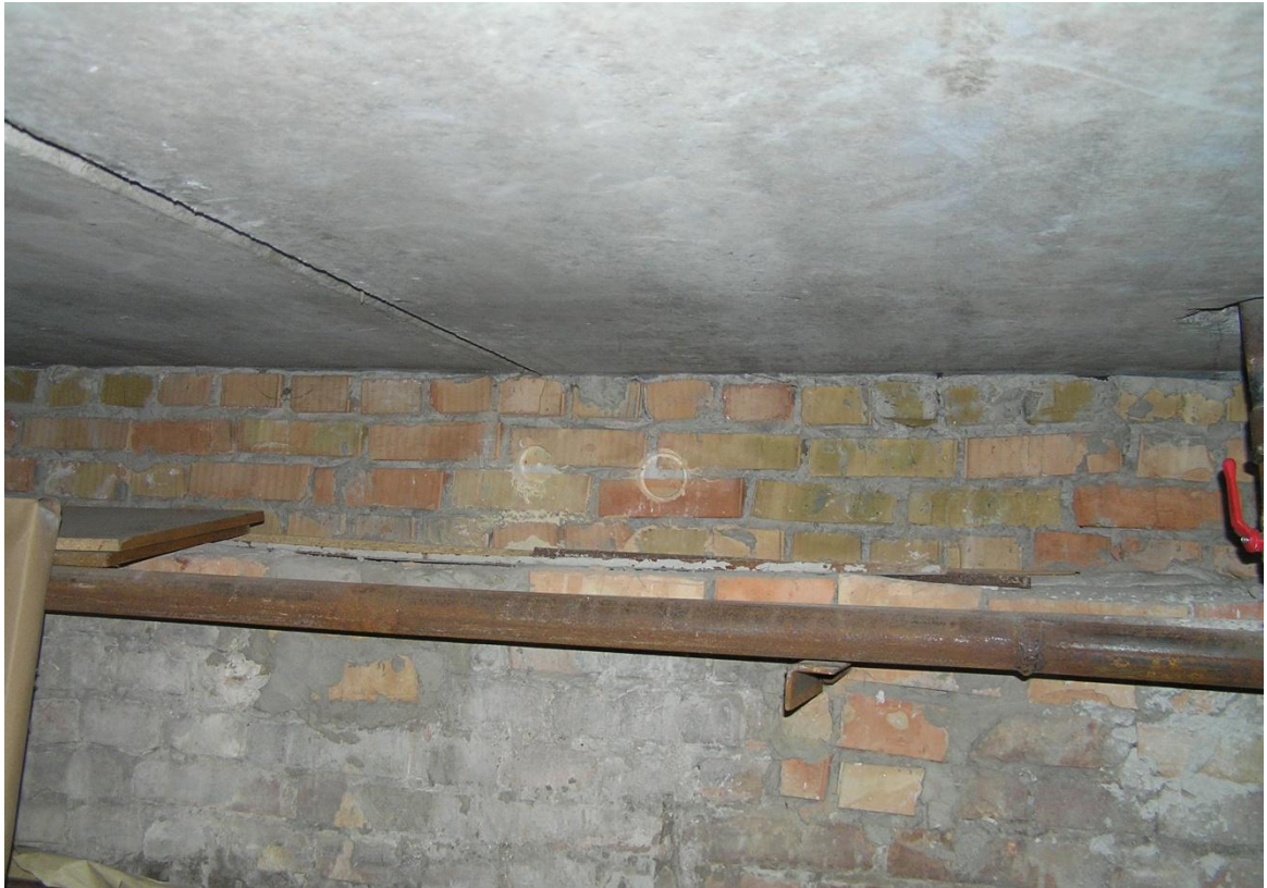
Рис. 3.11 Общий вид крайней продольной стены подвала и плит перекрытия
