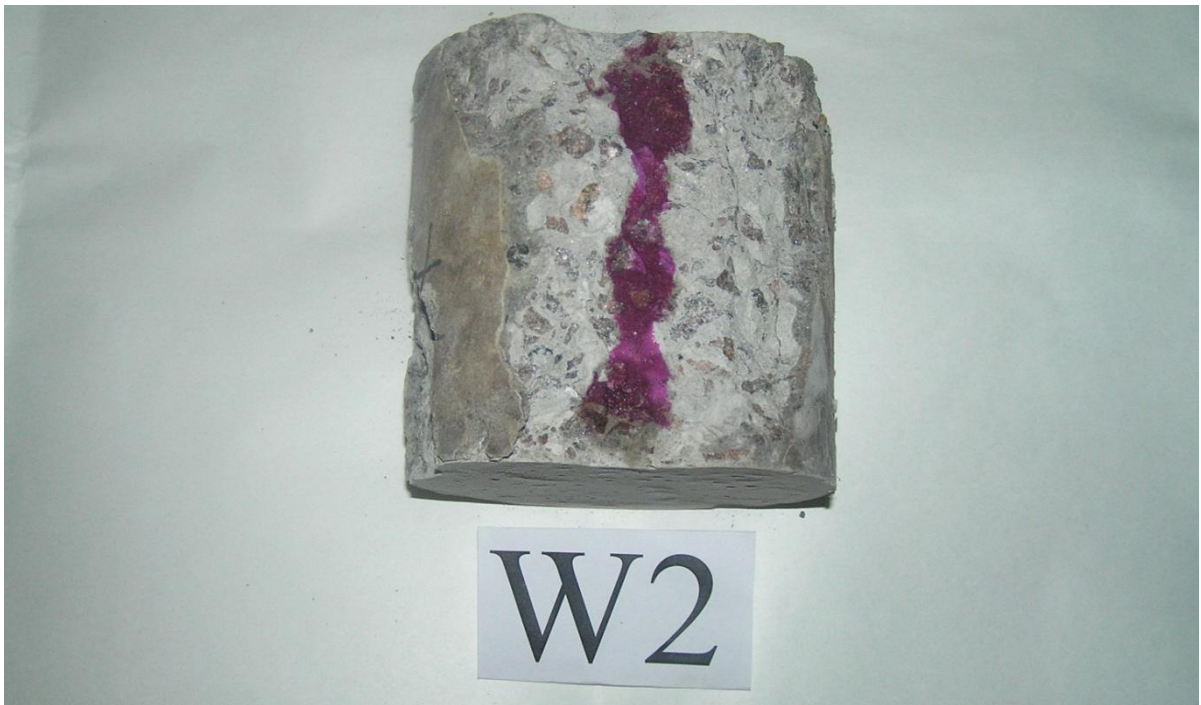
Рис. 3.6. Определение глубины карбонизации путем нанесения 1% раствора фенолфталеина.
