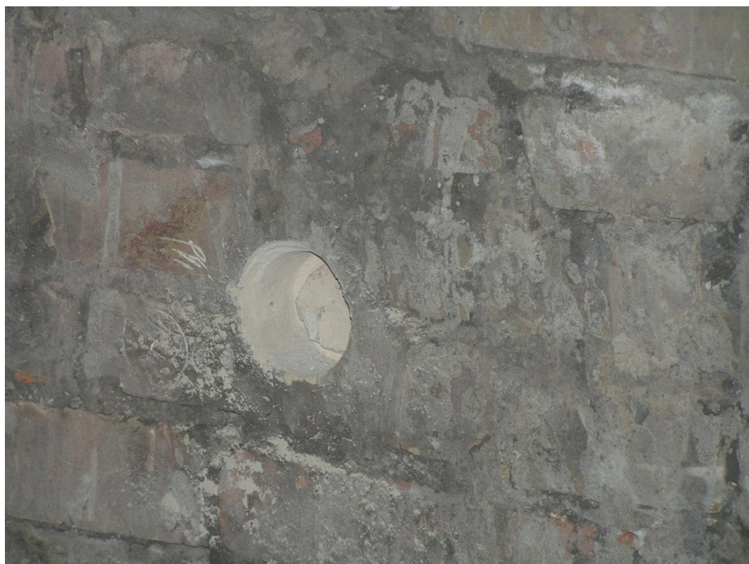
Рис. 3.14. Участок «старой» стены в месте отбора образца
