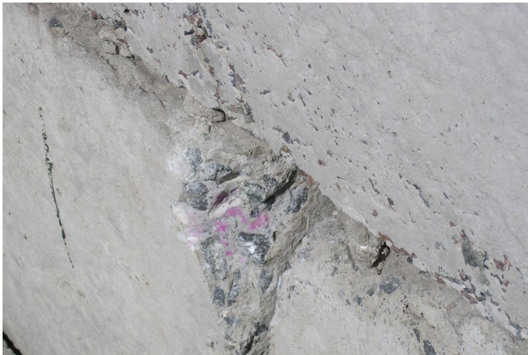
Рис. 3.12. Угловой участок фундаментного блока с отобранным образцом для определения глубины карбонизации
