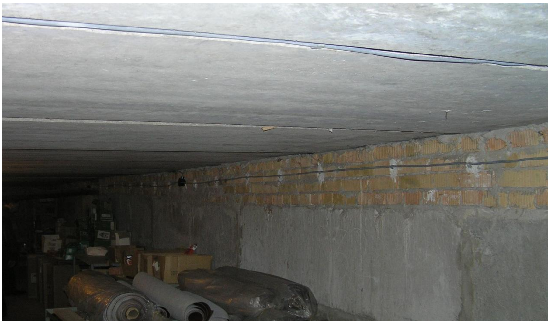
Рис. 3.9 Общий вид средней продольной стены подвала и плит перекрытия
