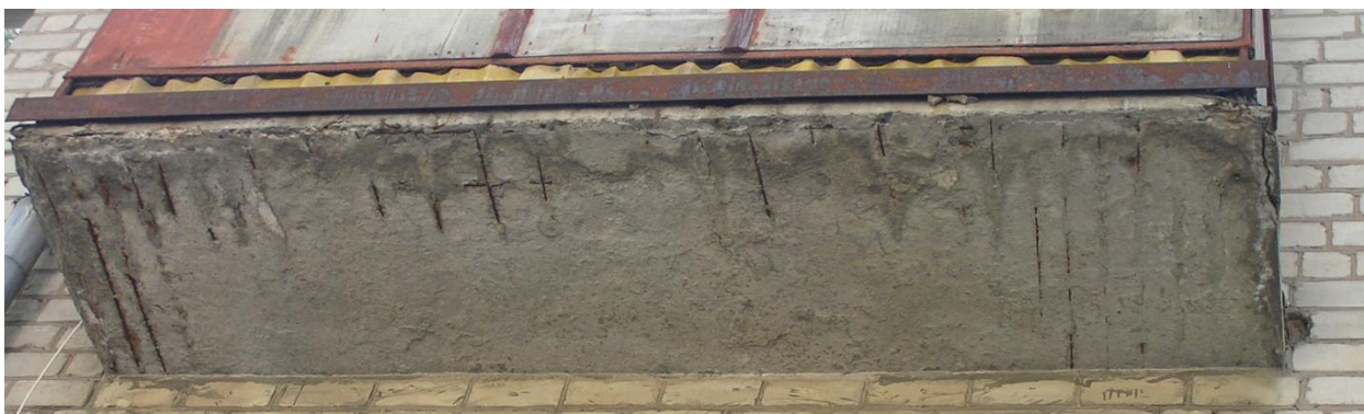
Рис. 3.32. Удовлетворительное техническое состояние
