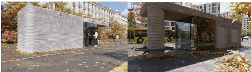
Рис. Проєкт надрукованої на 3D-принтері зупинки громадського транспорту - укриття від уламків: а – вигляд спереду; б – вигляд ззаду
