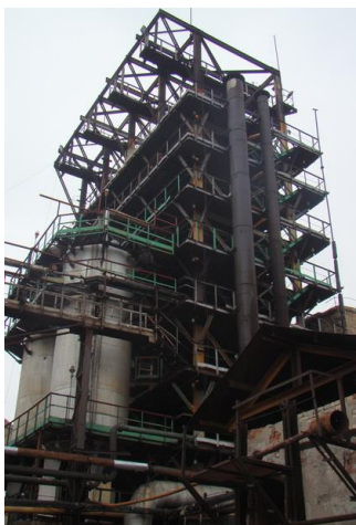
Рис. 1. Багатоповерхова етажерка та її розрахункова модель
