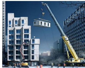
Рис. 8. Монтаж модулів
