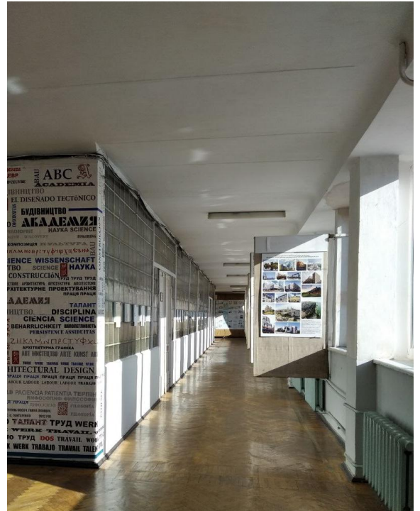
Рис. 2.9. Ліворуч – стіна відділу бібліотеки зі скляних блоків, праворуч – стіна, що виходить до коридору третього поверху в центральному корпусі (фото О. Грабовець)
