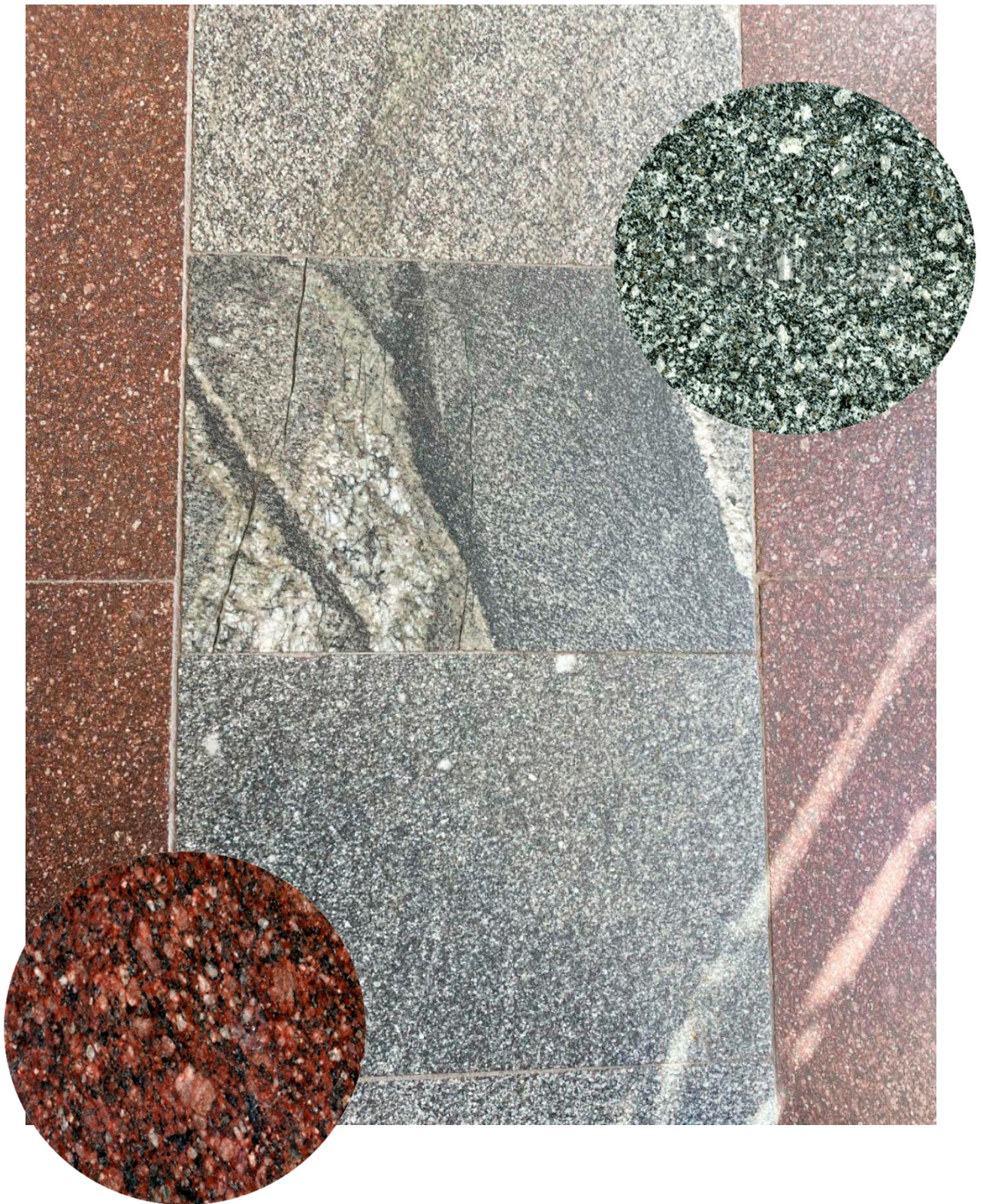
Рис. 1.10. Токівський (червоний) і кудашівський граніти підлоги історичного корпусу (фото студ. В. Микало)
