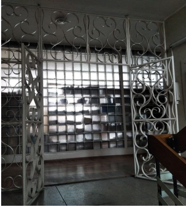
Рис. 2.9. Ліворуч – стіна відділу бібліотеки зі скляних блоків, праворуч – стіна, що виходить до коридору третього поверху в центральному корпусі (фото О. Грабовець)
