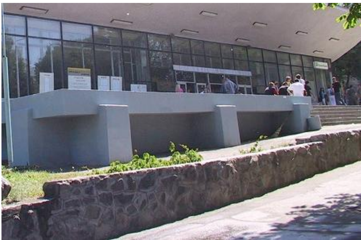
Рис. 1.1. Підпірна стінка з природного каменю – місцевого гранітогнейсу
