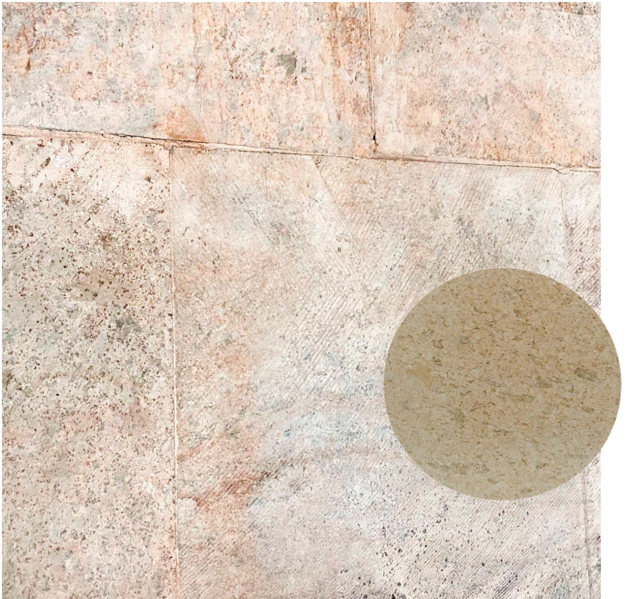
Рис. 1.15. Вірменські фельзитові туфи в облицюванні холу головного корпусу академії (фото студ. В. Микало)
