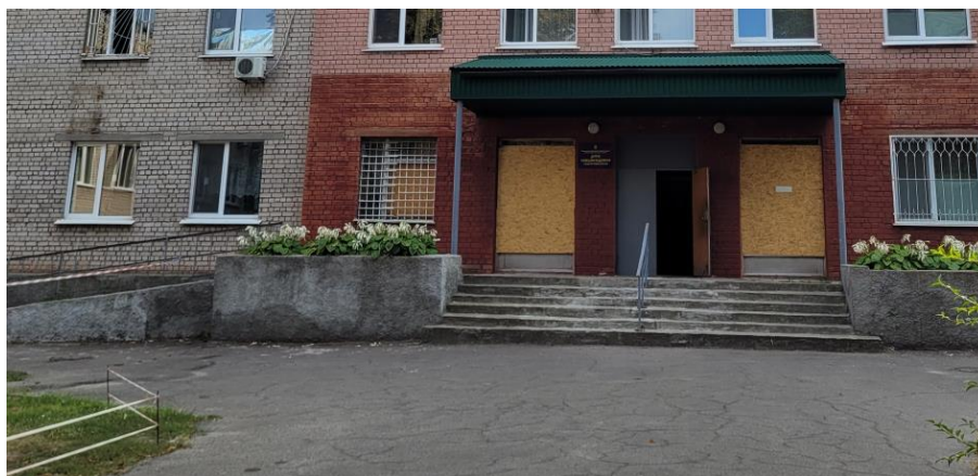
Рис. 1. Вхід до будівлі до початку реконструкції
