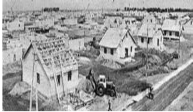
Рис. 6. Панорама будівництва в с. Лукаші
