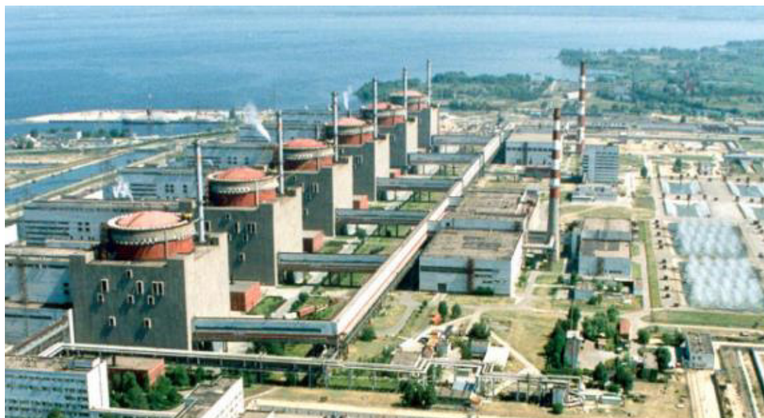
Рис. 3. Общий вид на Запорожскую АЭС с энергоблоками ВВЭР-1000
