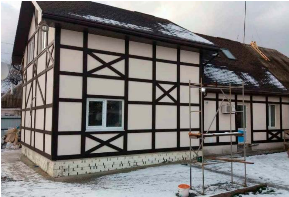
Рис. 1. Конструкция здания – прототипа из соломенных панелей «Life House Building»/ The construction of the building - a prototype of the straw panels "Life House Building"
