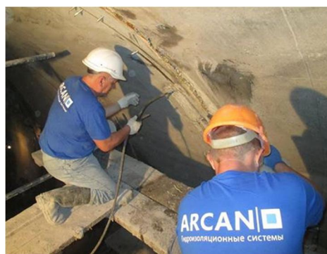
Рис. 4 Производство работ по герметизации трещин / Work on the sealing of cracks
