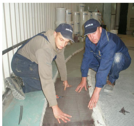
Рис. 3. Ремонт и усиление перекрытия шахты гидроагрегата № 1 / Repair and reinforcement of the overlapping of the mine of hydroelectric № 1
