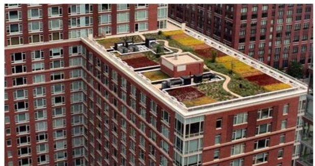
Рис.3. Екстенсивна зелена покрівля на плоскому даху / Extensive green roof on the flat roof
