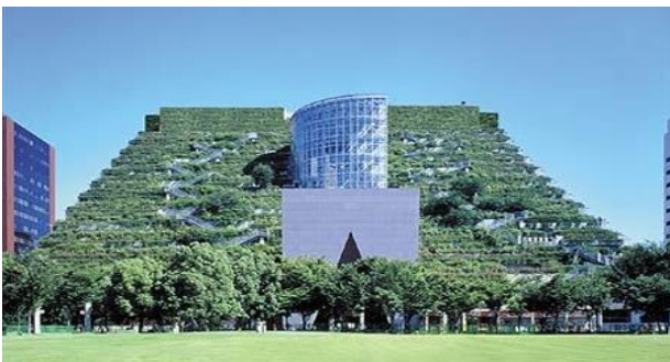
Рис..6. Интенсивна зелена покрівля на скатному даху / Intensive green roof to pitched roof
