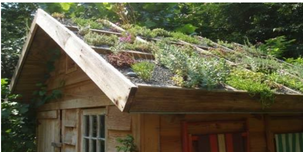
Рис.5 Екстенсивна зелена покрівля на скатному даху / Extensive green roofs to pitched roof
