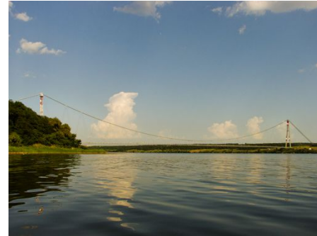
Fig.2. View of the ammonia pipeline at Dnepr River / Вид аммиакапровода на р. Днепр
