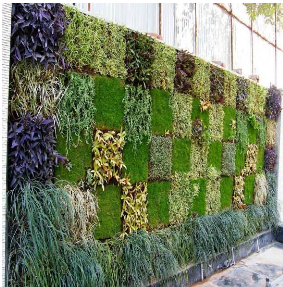
Рис.2. Пример декоративного озеленения одевающих (прижимных) подпорных стен / Example of decorative planting clamping retaining walls.
