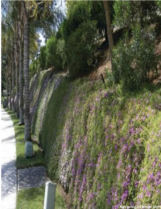
Рис.1. Пример озеленения одевающих (прижимных) подпорных стен (ландшафт приближен к естественному) / Example of planting clamping retaining walls (landscape close to natural).
