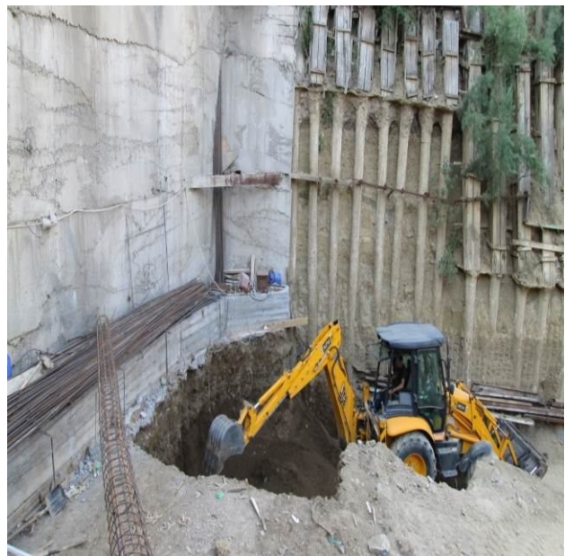
Рис.12. Один из примеров применения одевающей подпорной стены: Вид котлована строящегося здания в центре города Тбилиси. (Ул. Атенская №17.) / One example of using of the clamping retaining wall. View of the foundation pit of the building under construction in the center of Tbilisi, Ateni str. № 17.
