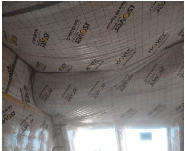
Рис. 3. Проведення Blower Door тесту / The process of Blower Door test
