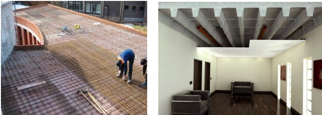
Рис. 1. Монолітне ребристе перекриття
