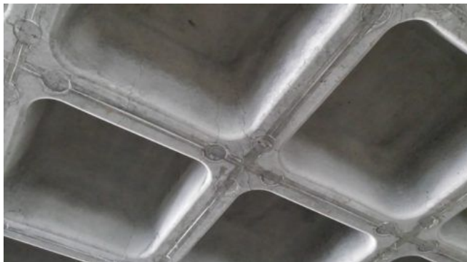
Рис. 2. Монолітне кесонне перекриття
