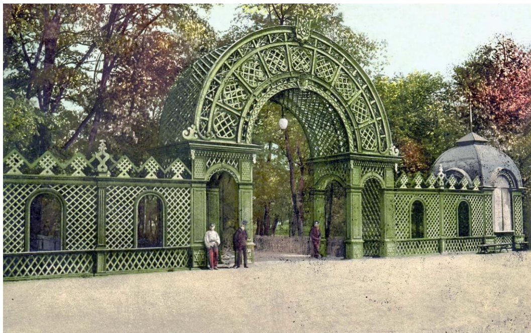
Рис. 26. Арка входа в Городской сад
