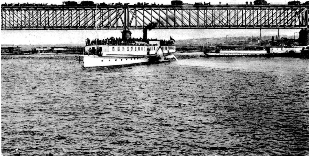
Рис. 42. Днепровский (Амурский) железнодорожный мост
