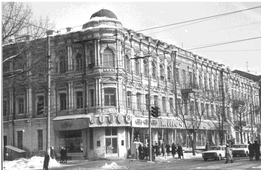
Рис. 149. Здание бывшей гостиницы «Большая Московская» на проспекте К. Маркса, № 98 (фотография Г. И. Гуляева 1985 года)
