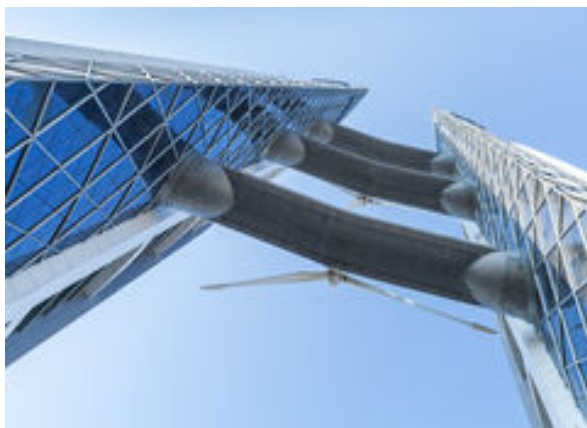
Рис. 4. Вид на горизонтальные дугообразные мостовые опоры ВТЦ в Бахрейне
