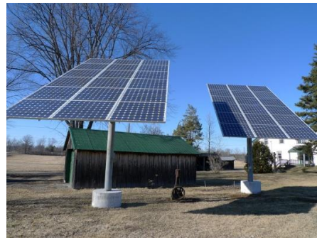
Рис. 9. Гелиоустановка на специальной подставке
