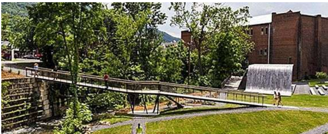
Рис. 2.4 Загальний вид мосту
