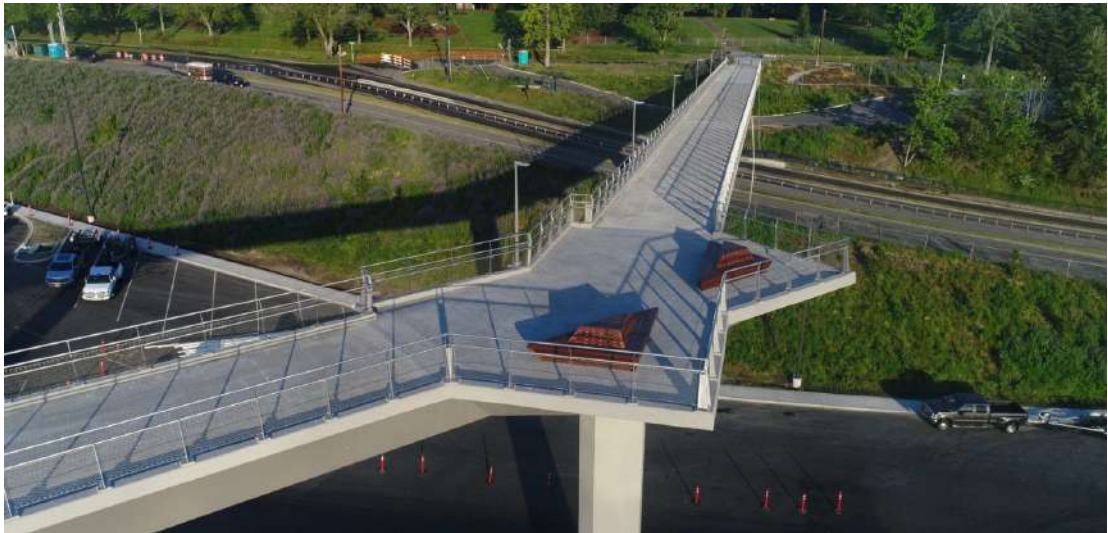
Рис. 2.1 – Загальний вид на міст
