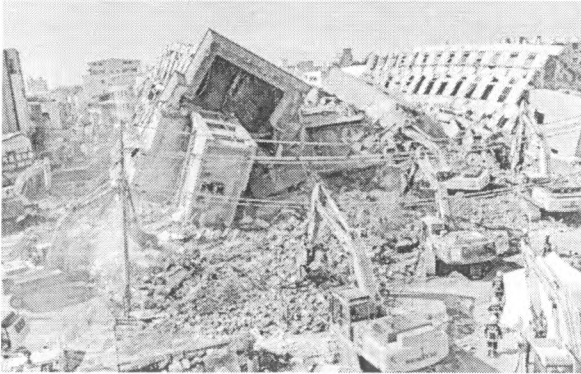
Рис. 4. Розбирання руйнувань одночасним використанням декількох екскаваторів з різним робочим обладнанням
