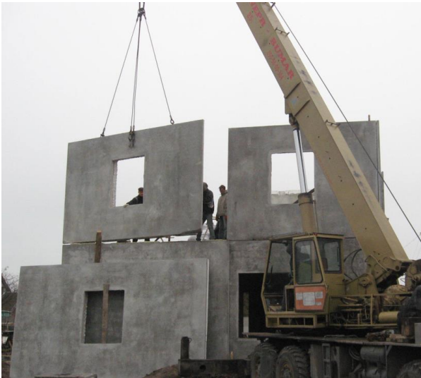
Рис. 17. Монтаж тришарових панелей
