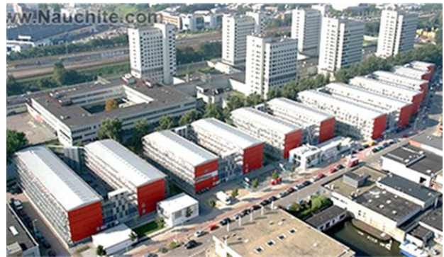
Рис. 8. Найбільший у світі мобільний кампус «Keetwonen», споруджений із морських контейнерів (Амстердам, Нідерланди)
