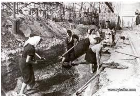
Рис 2. Укладання та ущільнення бетонної суміші
