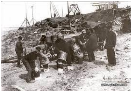
Рис 1. Виконання земляних робіт вручну
