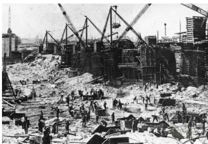
Рис. 3. Будівництво Дніпровської (Запорізької (ДніпроГЕС ім. В. І. Леніна))
