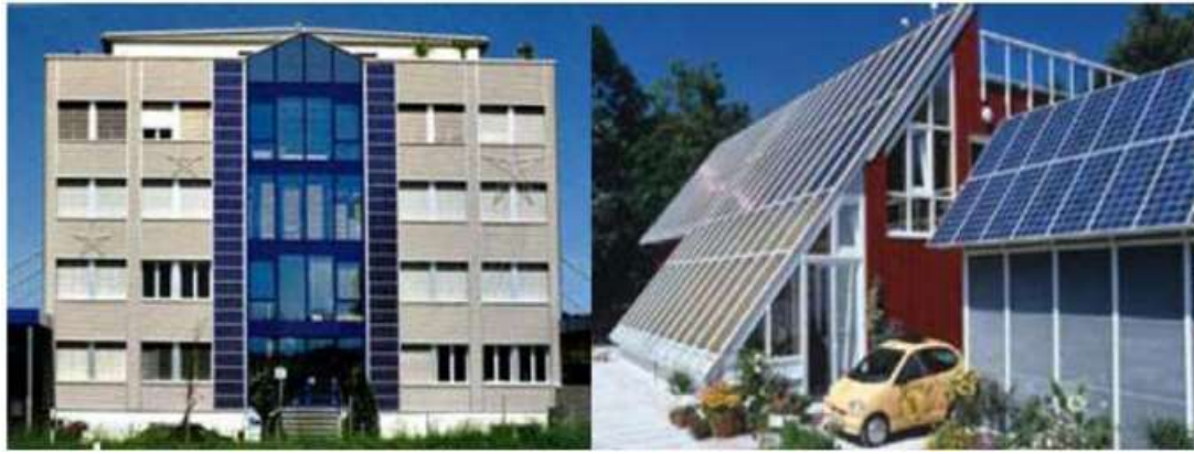
Малюнок № 37: Розташування та використання фотоелементів у будівлях.
