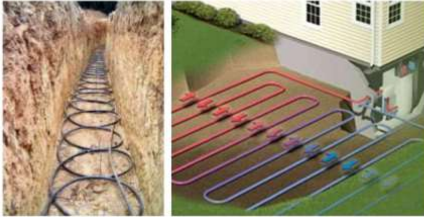
Малюнок № (43): Використання геотермального тепла для охолодження.
