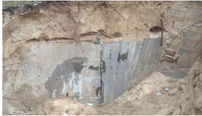
Рис. 2. Місце розробки ґрунту
