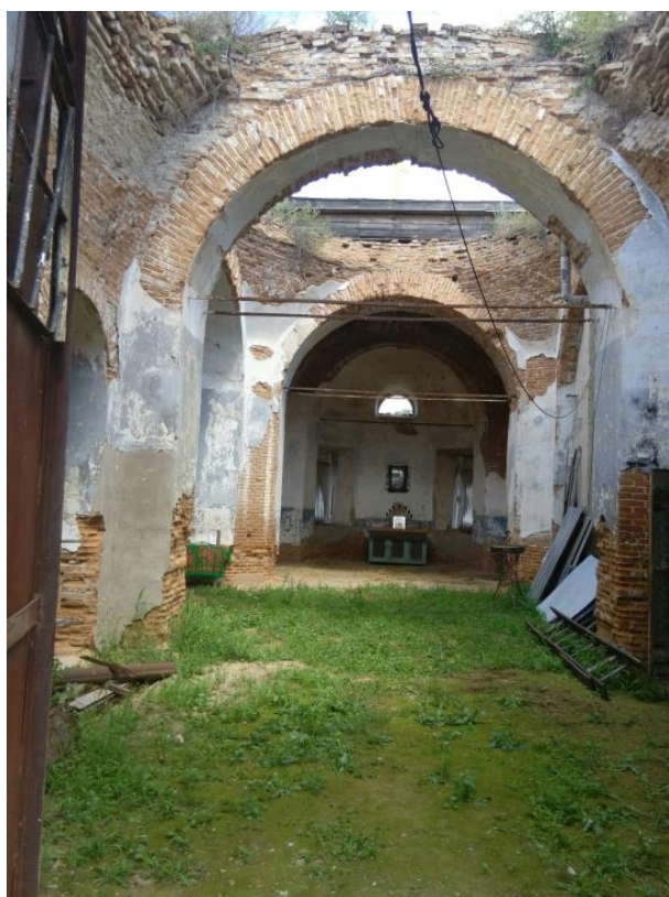
Рис. 2. Внутрішня центральна частина будівлі церкви та вітвар (вид із центрального входу на західній стороні)
