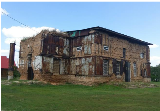
Рис. 1. Загальний вигляд будівлі церкви з південного заходу
