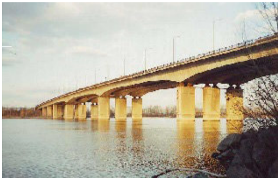
Кайдакский мост с водоводом «Резонанса» – питьё для Левобережья
