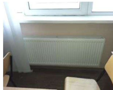
б) часткова заміна опалювальних приладів
