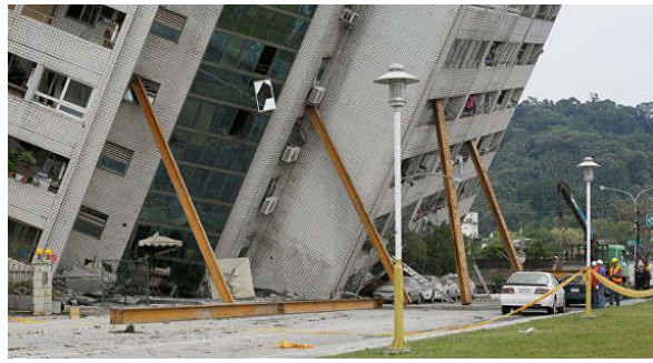
Рис. 14. Закріплення нестійких об'єктів при ліквідації наслідків землетрусу на Тайвані (2018 р.):
