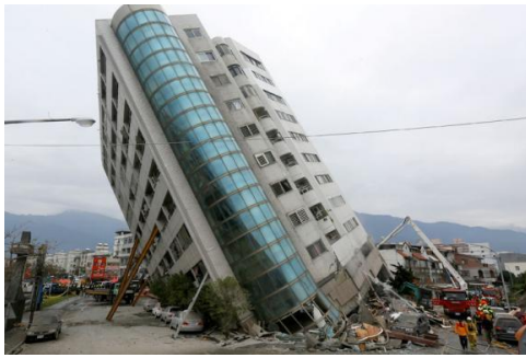
Рис. 14. Закріплення нестійких об'єктів при ліквідації наслідків землетрусу на Тайвані (2018 р.):
